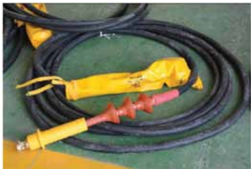
شکل ۶: کابل تغذیه ترانسفورمر
